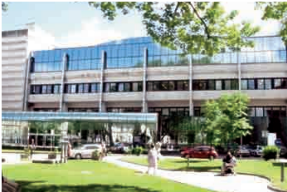
STAVBA ONKOLOŠKEGA INŠTITUTA
